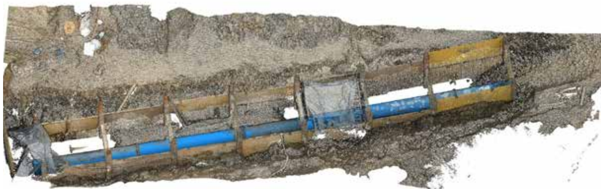
Superposition du modèle numérique avec le nuage de points (changement d'angle de vue)
